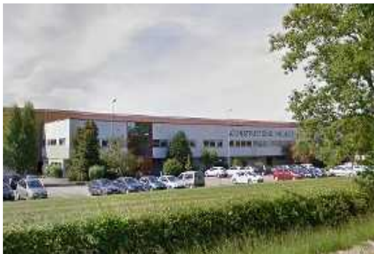
Site d'activités des Constructions Nogues – Saint-Fargeau. Source : Citadia Conseil
